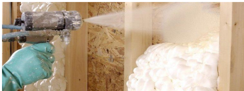
Figure II.13 Isolation par projection
