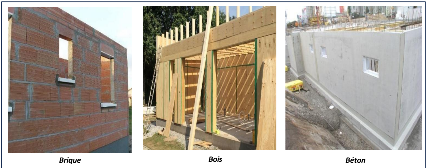
Figure I.3 Différents types de matériaux du mur
