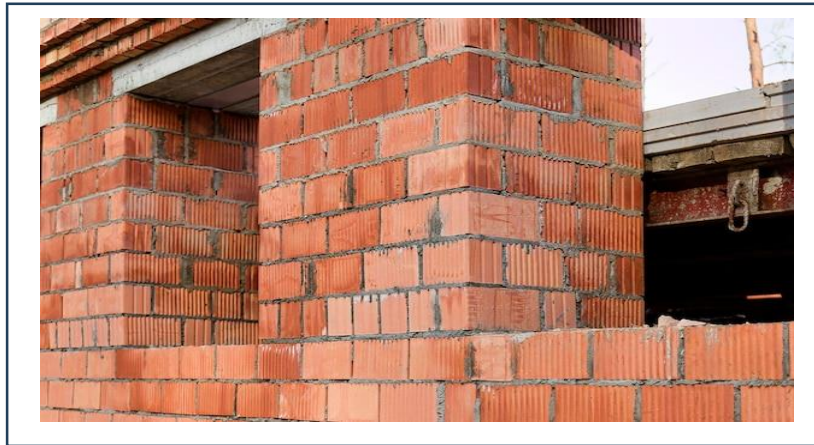
Figure I.5 : Mur en maçonnerie [2]
