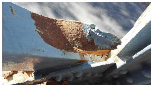
(d) Déchirure d'une diagonale
