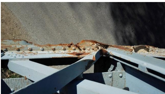
(c) Déformation plastique de la diagonale
