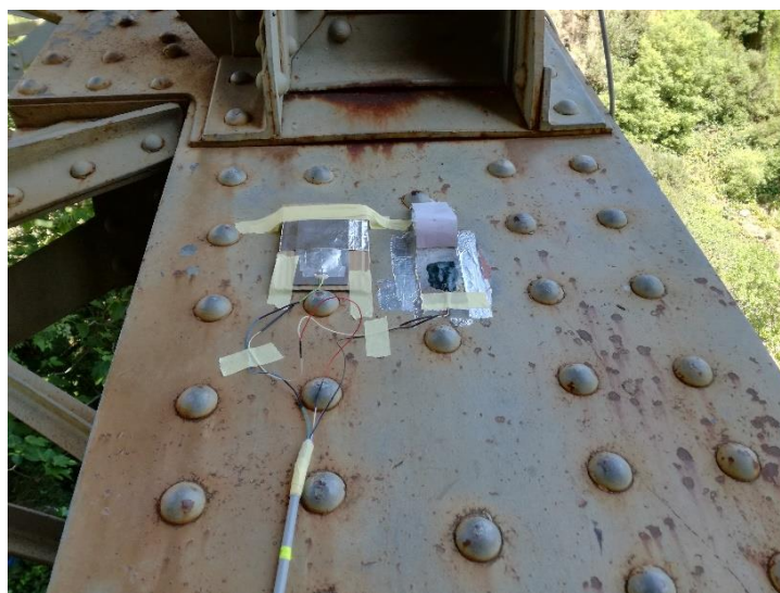
Photo 3 – Jauge de contrainte placée sur la poutre principale.
