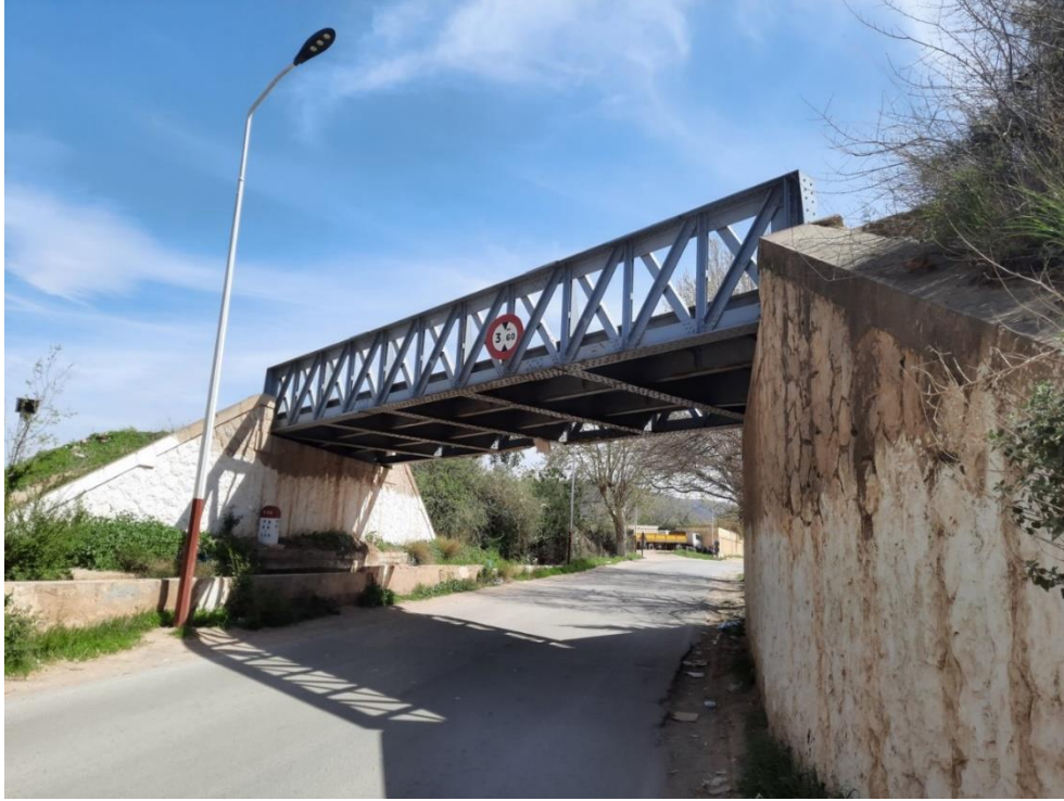
Figure V-14 – Vue sur le côté nord « pont de Ouled Mimoun ».
