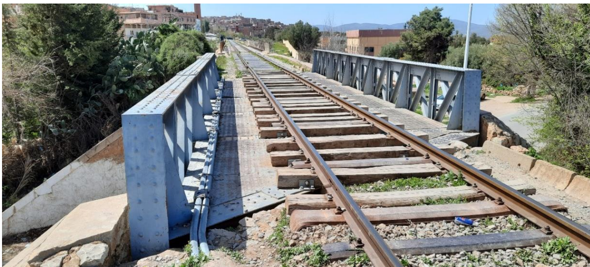
Figure V-15 – Vue sur le tablier du pont « Ouled Mimoun ».
