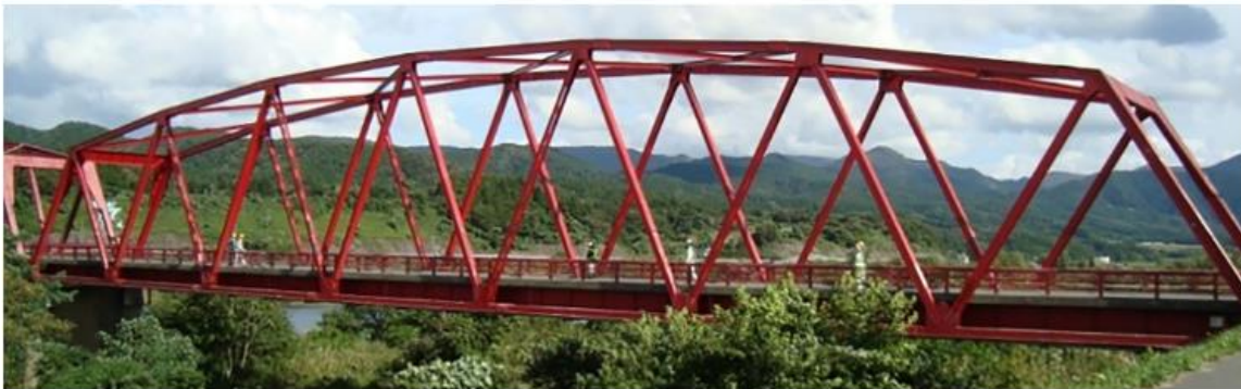
Figure II-10 – Pont en treillis existant [88].
