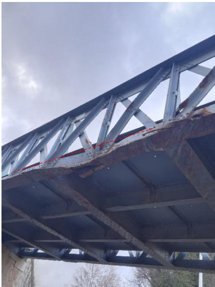
(a) Déformation plastique hors plan
