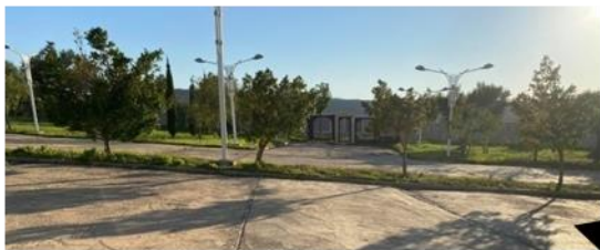
Figure 59 : Accès mécanique secondaire
