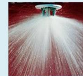
Le sprinkler relié à la colonne humide
