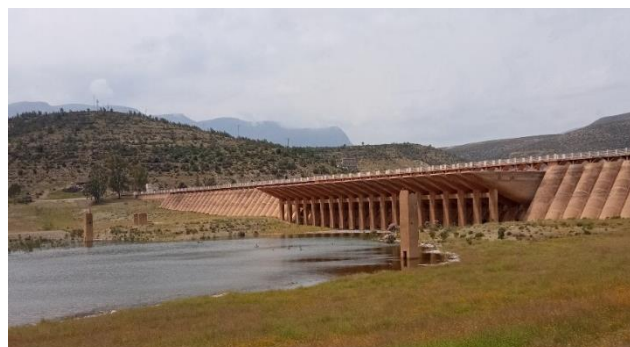
Photo réelle 1 : La digue Evacuateur de crue du barrage Beni Bahdel.
