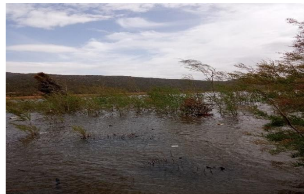
Photo réelle 3 : La digue col-nord du barrage Beni Bahdel.
