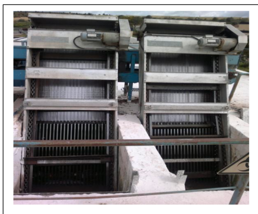
Figure 6 : Dégrilleur mécanique
