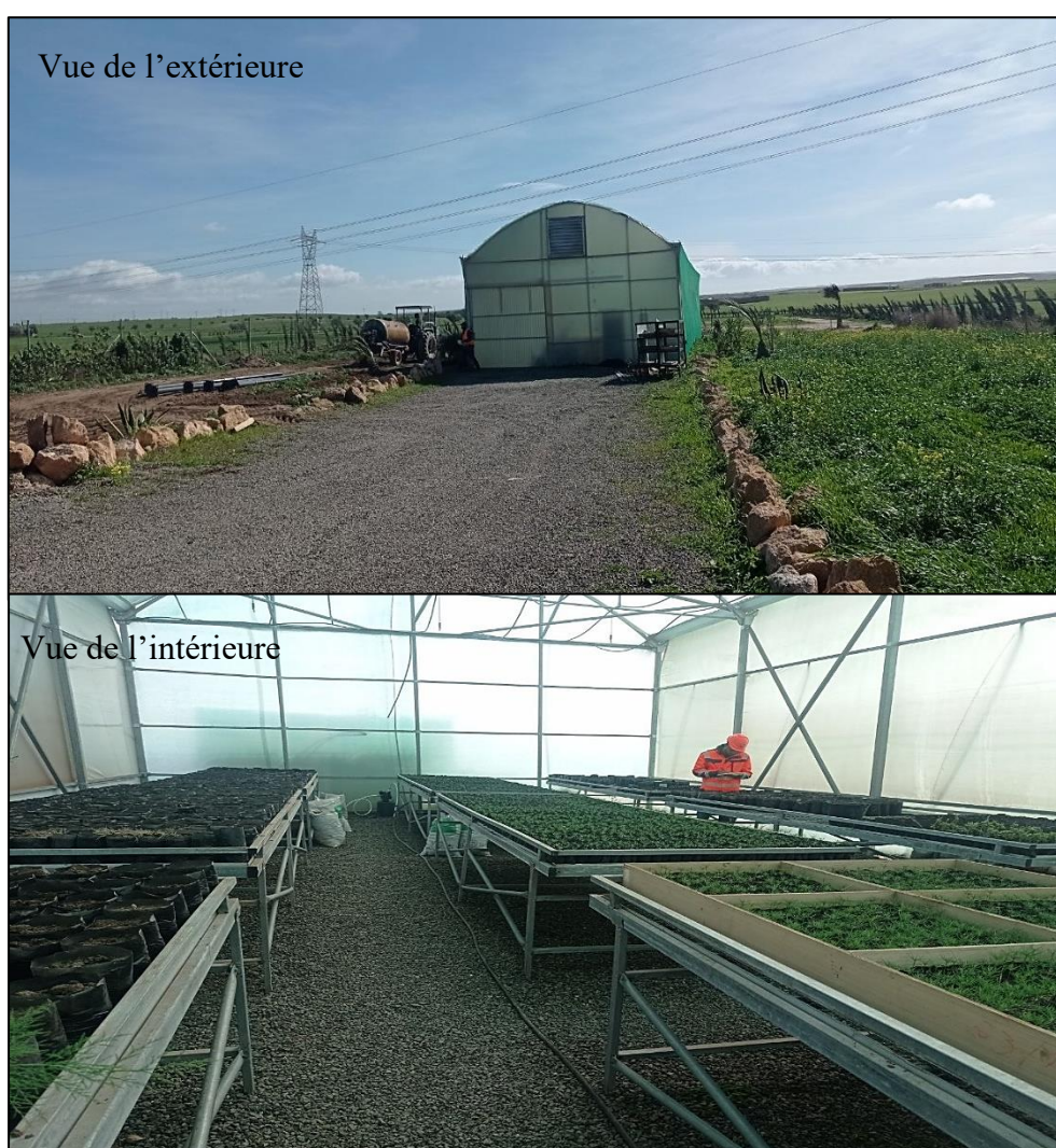
Figure 34 : Photos montrant la structure de la pépinière de Knauf
