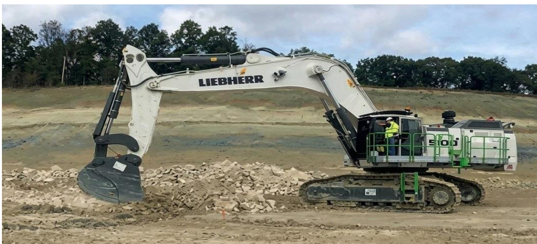
Figure 12 : Opération de décapage réalisée à l'aide d'une pelle hydraulique
