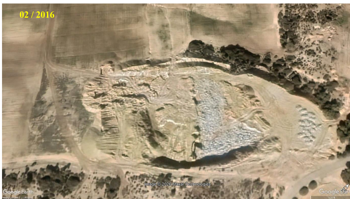
Figure 48 : État du site de la carrière de Menatsia en phase d'exploitation en 2016
