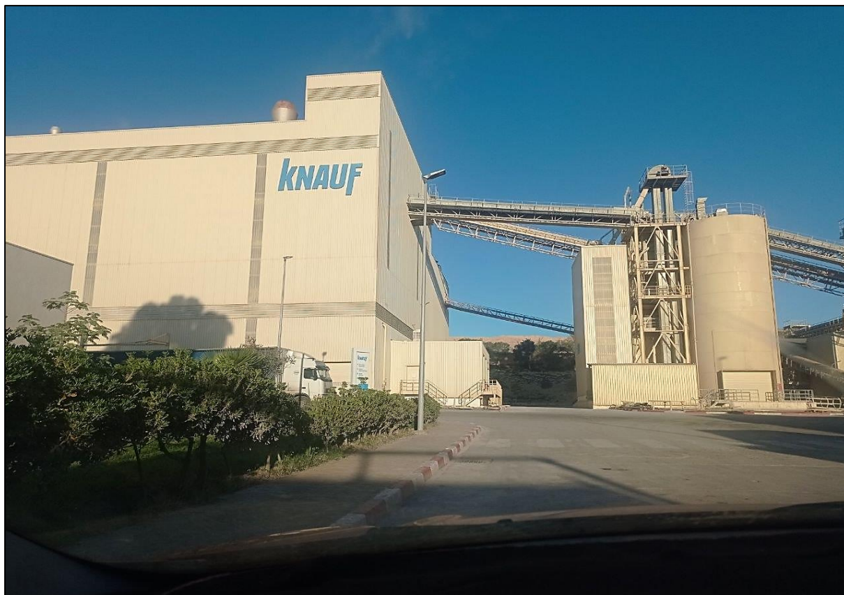
Figure 11 : Vue générale de l'usine de plâtre Knauf à Oran.
