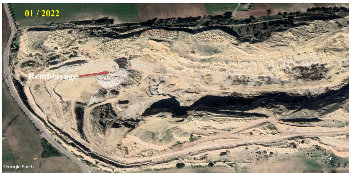
Figure 43 : Vue satellite de l'évolution des travaux de remise en état de la carrière
