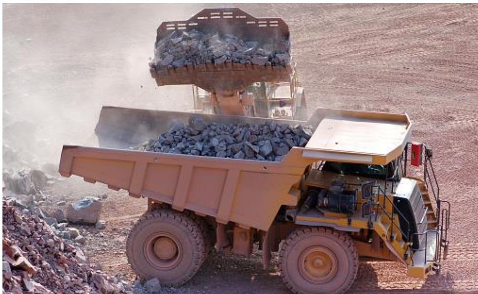
Figure 19 : Etape de chargement des matériaux à l'aide d'un chargeur sur pneus
