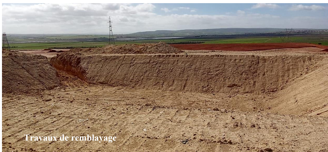
Figure 28 : Photo de terrain illustrant l'opération de remblayage dans la carrière de Fleurus
