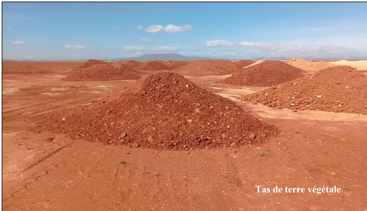
Figure 30 : Mise en place de la terre végétale dans la carrière de Fleurus
