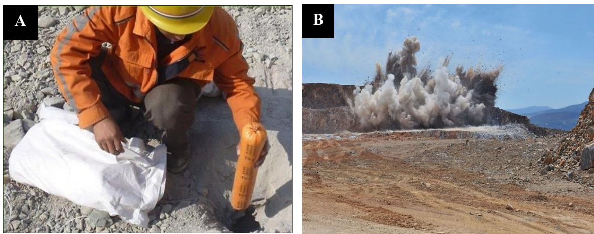
Figure 17 : A ; Chargement d'un trou de mine et B ; exemple d'un tir de mine
