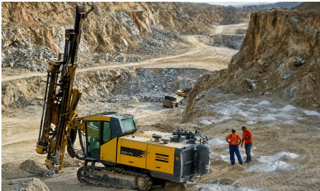
Figure 14 : Sondeuse Atlas copco destinée pour les travaux de foration
