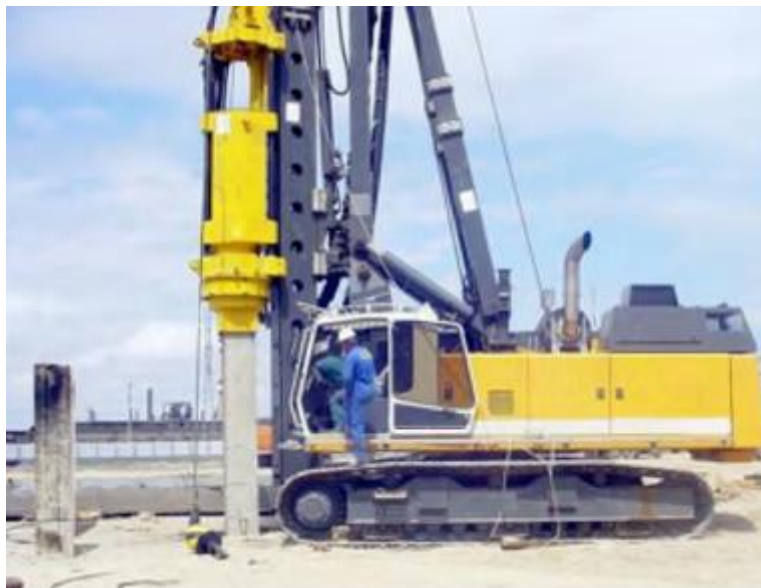
Figure 4.5:Pieu vibro-foncé.
