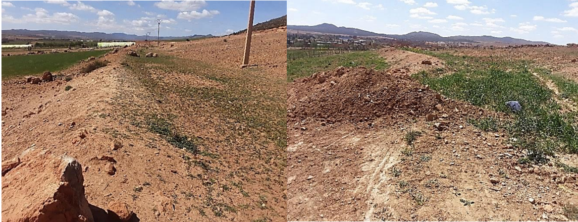
Figure 38 : Berme en terre (levée en terre).
