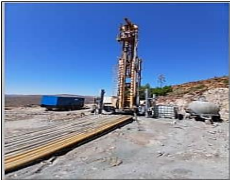
Figure 1 : Chantier de forage à Beni Bahdel (23 Septembre 2025).
