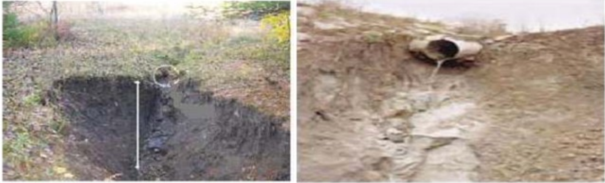
Figure 1.14: Concentration d'eau vers la pente
