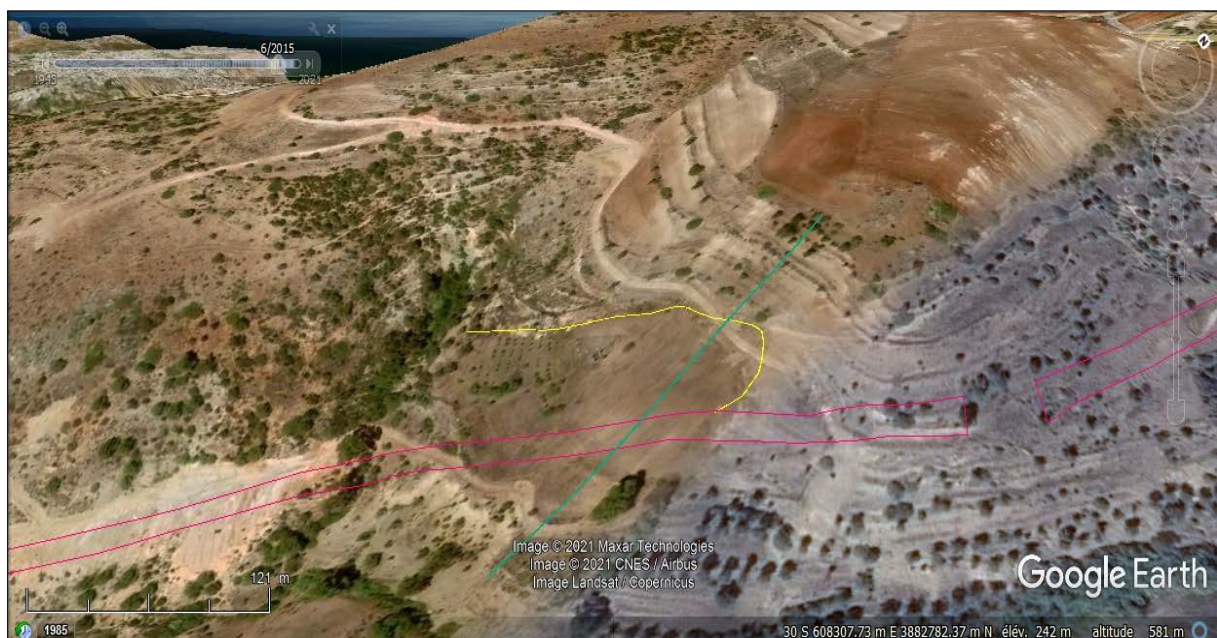
Figure 4.4: Localisation du point de glissement sur image satellitaire [20]
