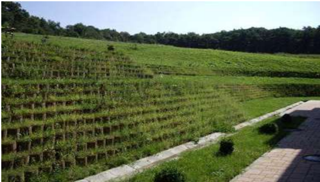
Figure 3.9: Une méthode de confortement “végétation” [16]
