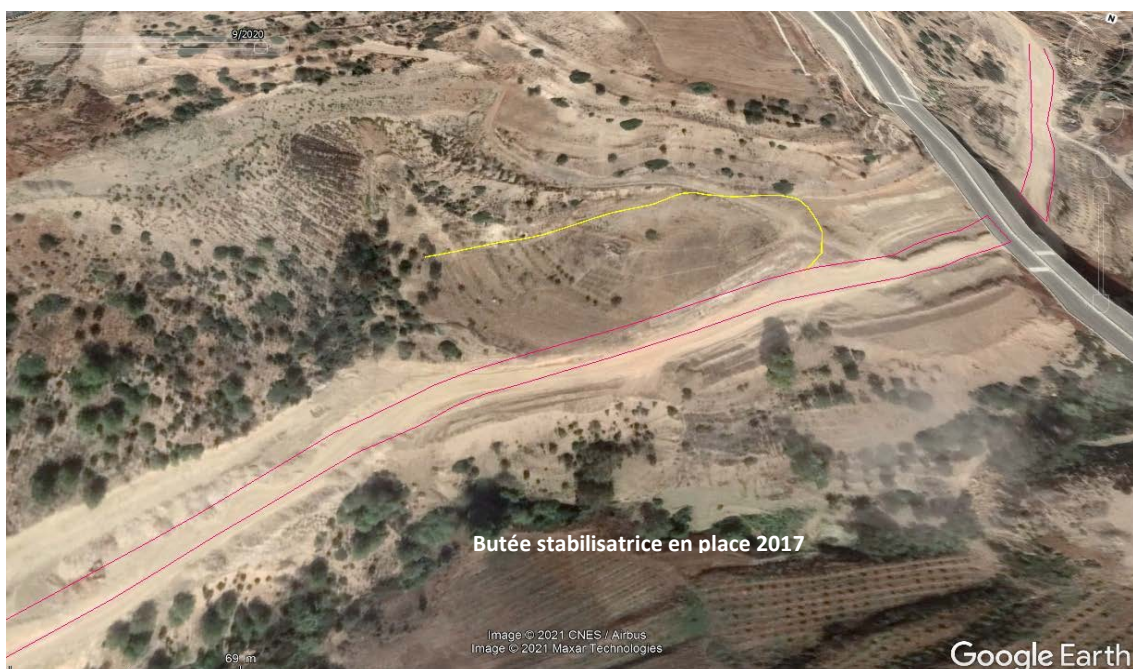
Figure 4.14 : Butée stabilisatrice en place 2017 [20]
