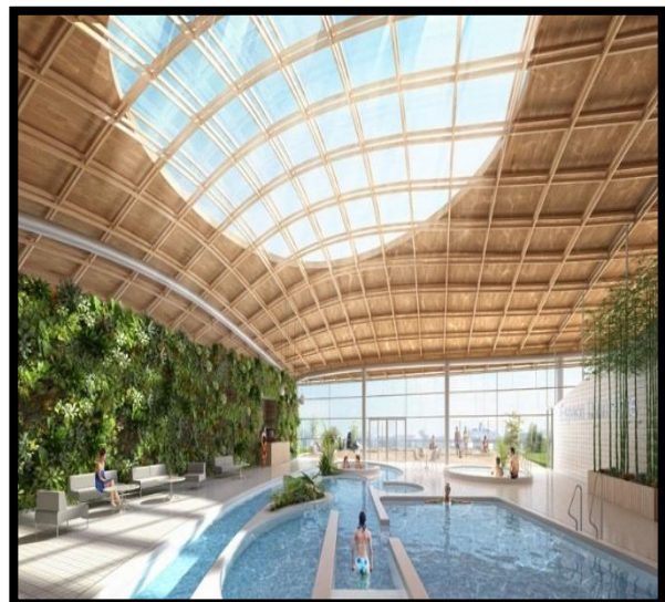
Figure 169 : Charpente en bois lamellé collé
