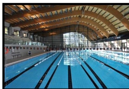
Figure 111 : Palais des sports nautiques à Kazan
