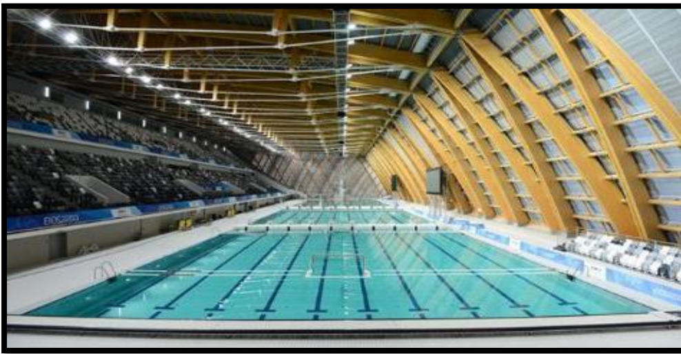
Figure 180 : Structure en bois lamellé collé
