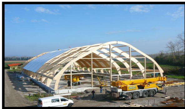
Figure 58 : Bâtiment agricole de Belle chasse
