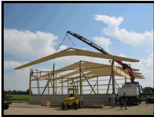
Figure75 : Montage d'un bâtiment de stockage
