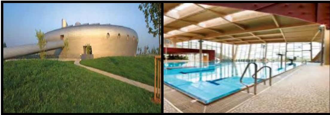
Figure 74 : Centre sportif et culturel « La Coque » - Luxembourg (portée 40 m)
