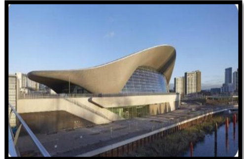
Figure 122 : Centre aquatique London (vue extérieure)
