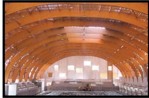
Figure 60 : Export – Bâtiment Sportif
