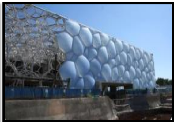
Figure 161 : Façade en cour de construction
