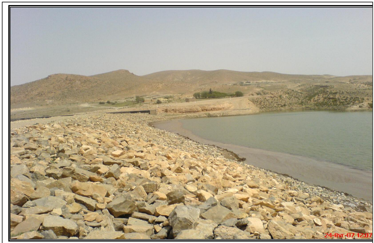
Photo 3.1 Vue générale Digue Kreirech
