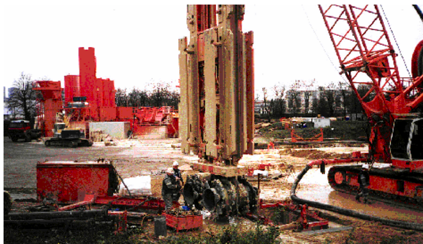
Fig 2.10 Hydrofraise : Excavation d'un Panneau
