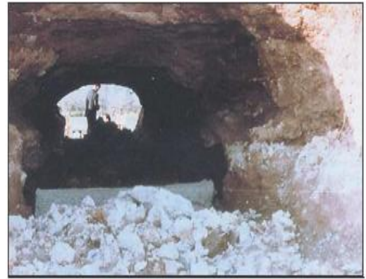
Fig 1.15 Renard dans un Barrage ; (Lautrin; 2002)
