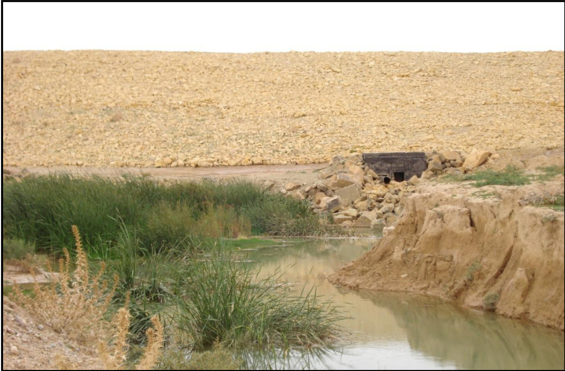
Photo 3.4 Coté aval de la digue
