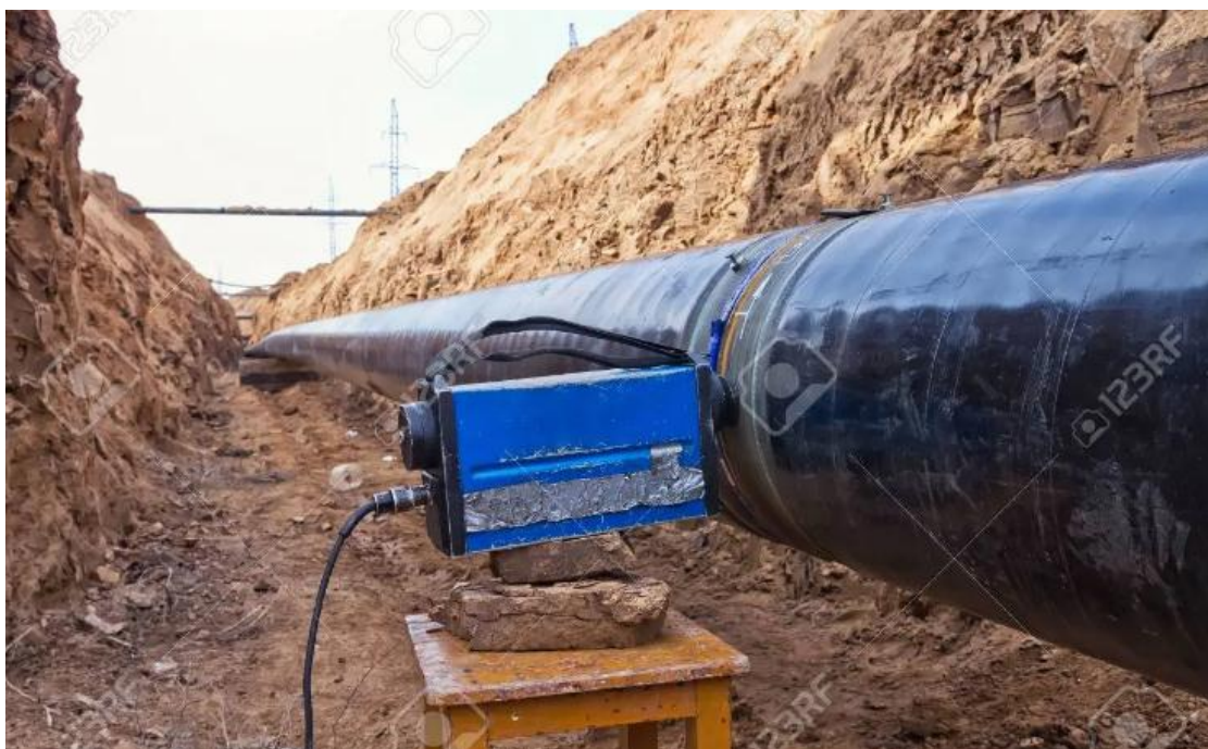
Fig I.24 Contrôle radiographique des joints soudés fixes de la tuyauterie d'alimentation en gaz haute pression à l'intérieur de la tranchée
