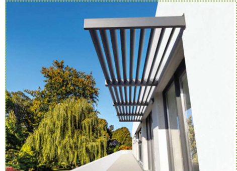
Photo 43 : brises soleil horizontaux Source : ( https://www.usine-online.com/brise-soleil-suspendu-sur-mesure/1896-brise-soleil-horizontal-lames-fixes-sur-mesure.html , s.d.)
