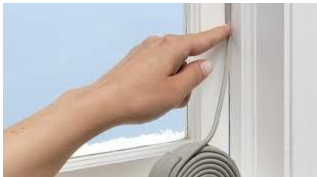
Figure 2.5: Isolation des fenêtres [17]
