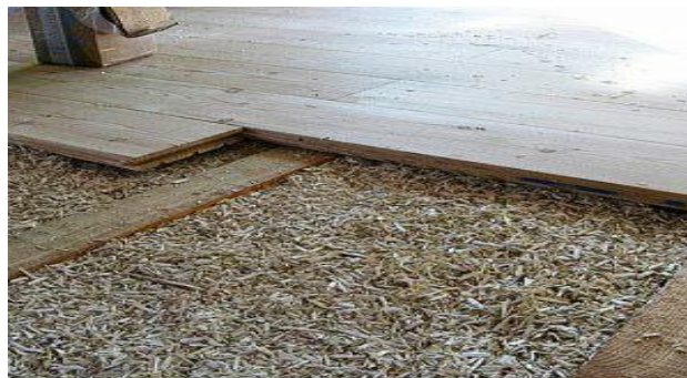
Figure 2.6 : Isolation des planchers [18]
