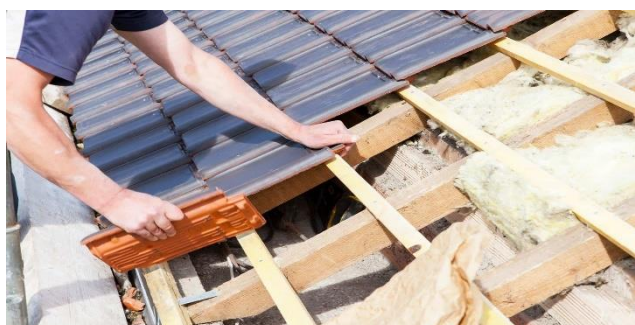
Figure 2.4 : Isolation des toitures [16]
