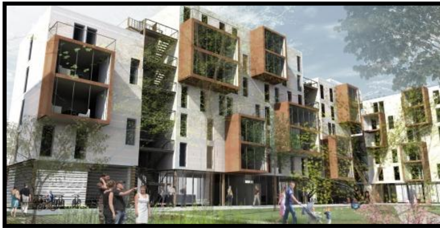
Figure 48. Logements étudiants Lyon.
