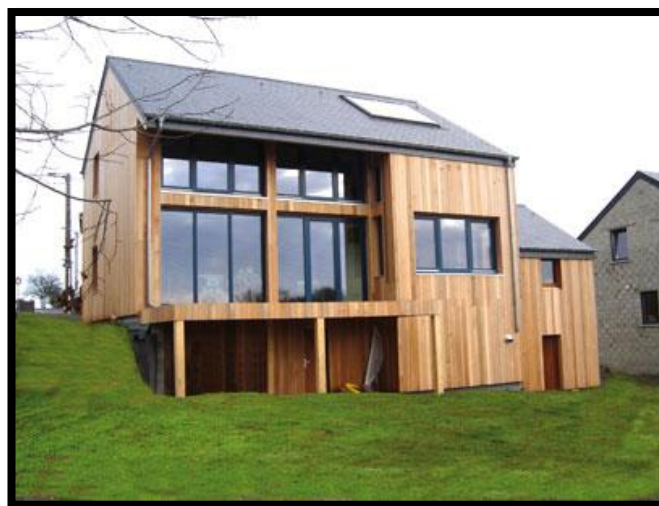
Figure 10. Un exemple de maison passive
