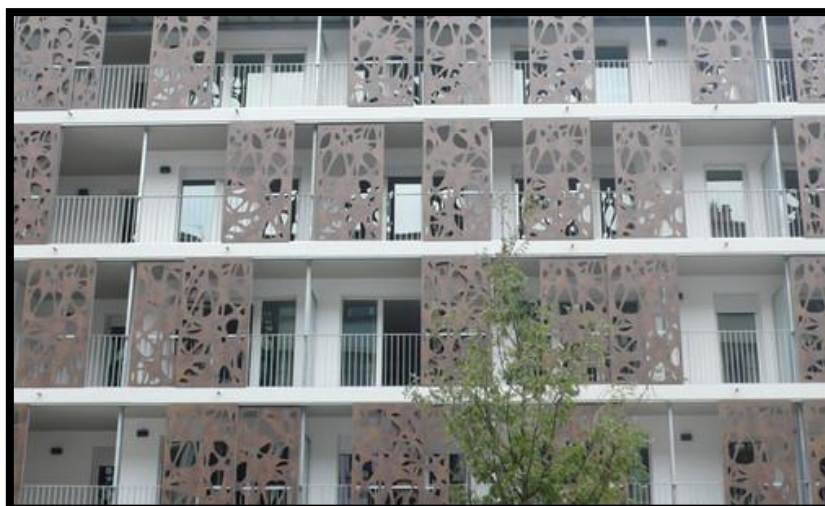
Figure 50. 22 Logements-Lot H2-ZAC de Bonne.
