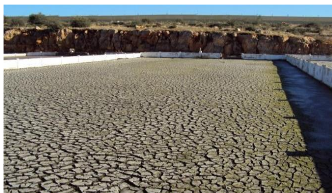
Figure III.12 : Lits de séchage.
