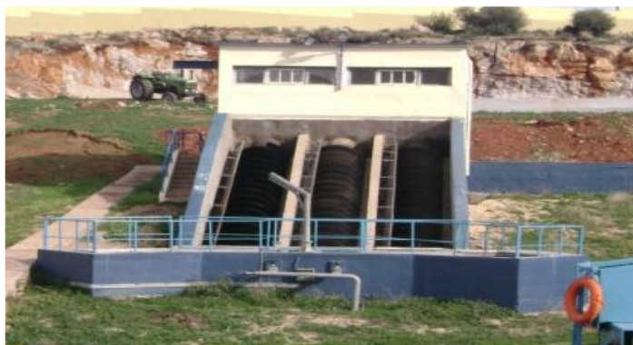
Figure III.9 :Vis de recirculation.
