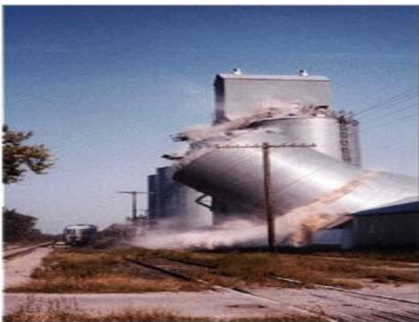
Figure I-4 : Effondrement d'un silo [f-4]
