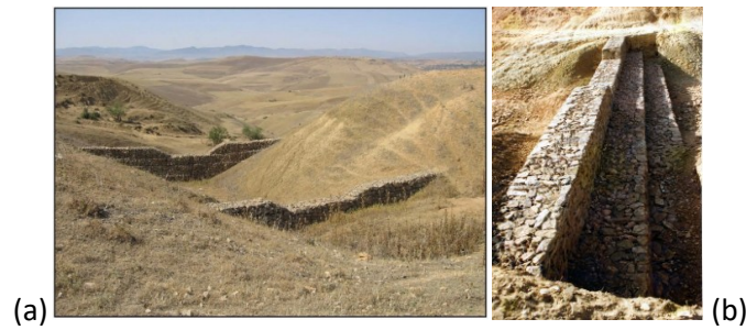
Figure 15. (a) Correction torrentielle dans la région de Tlemcen [23] ; (b) Gabion en pierre sèche (source : Établi par l'auteur).
