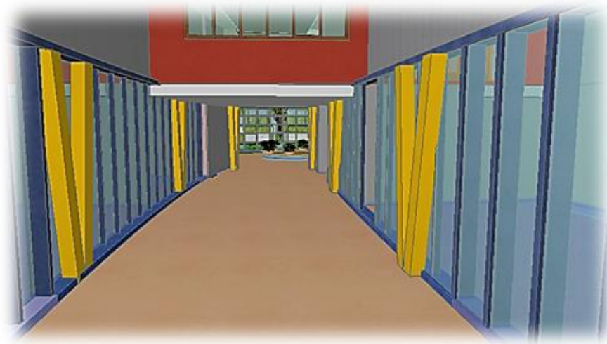
Figure 76 : Des contreventement dans le parcours privé des étudiants
