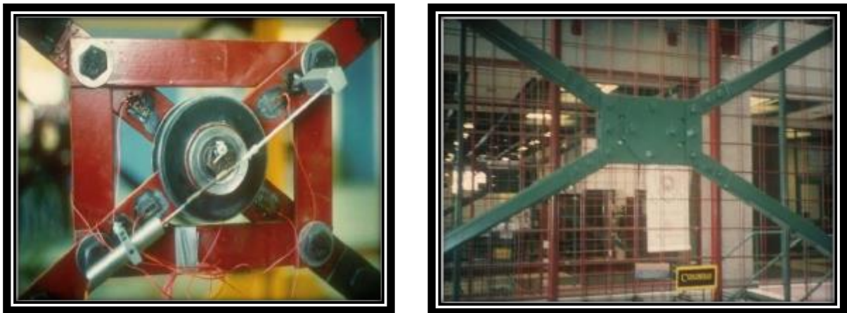
Figure 2.8 : L'amortisseur de Pall et son installation [11]
