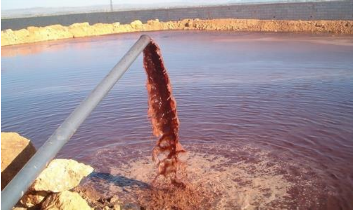
Figure 7 : Bassin de stockage des margines (Taounate Francophone, 2014)
