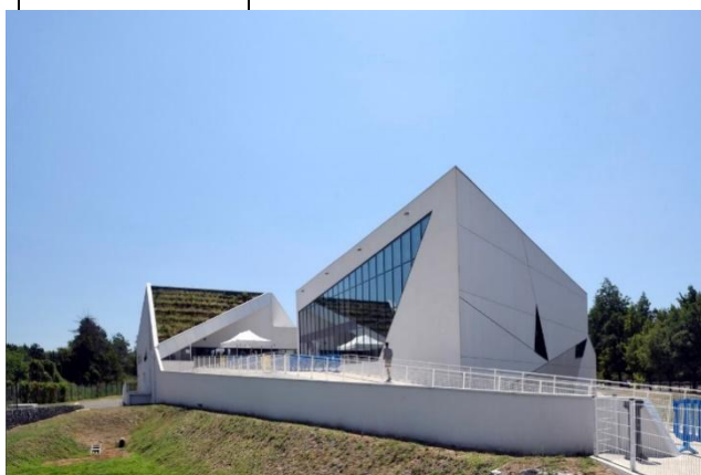
Figure 28 centre aqualudique de l'Épervière
