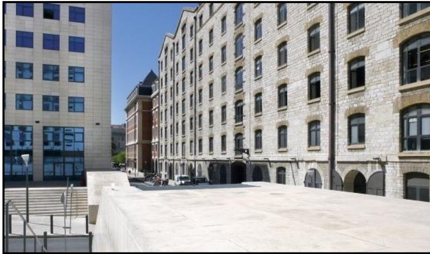
Photo 3 : La friche portuaire de la Joliette à Marseille transformée en pôle tertiaire (France). Source : Emmanuelle Real, op.cit.
