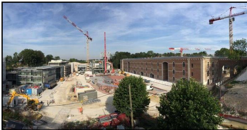
Photo 13 : Vues sur le casernement et les écuries au cours de la première phase des travaux. Source : Le Moniteur 372
