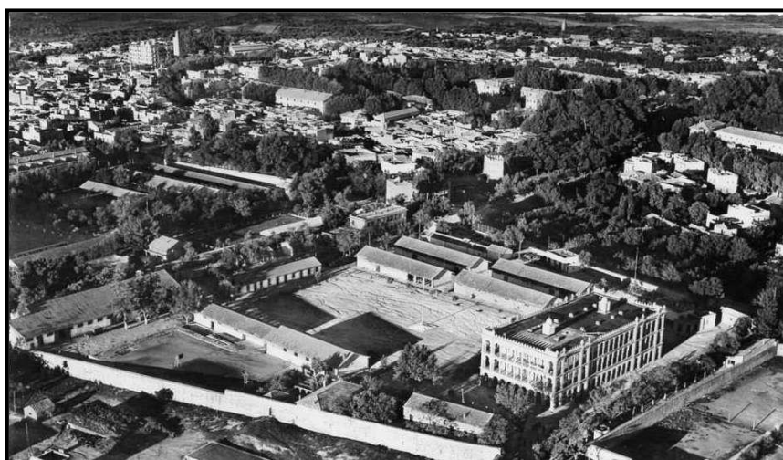
Photo 24: Vue générale de la caserne Bedeau en 1985. Source : Delcampe 538
