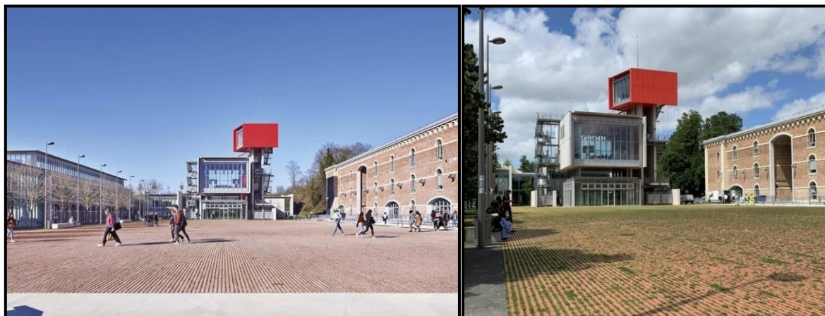
Photo 16 : Vues sur la place d'armes et la tour signal. Source : Archello 379
