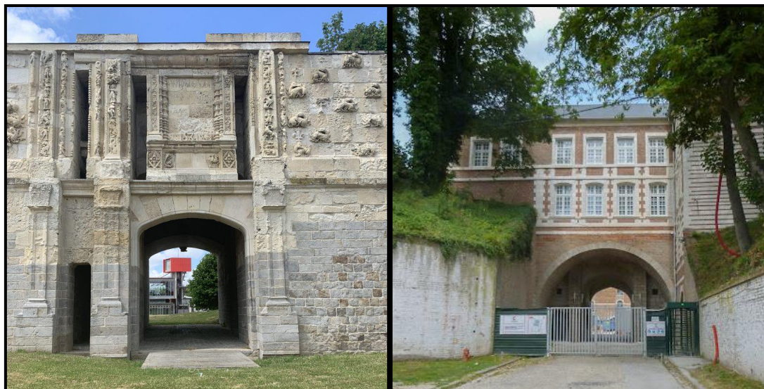
Photo 15 : Vues sur la porte François 1er et la porte Montrescu servant d'accès au campus. Source : Université de Picardie 376
