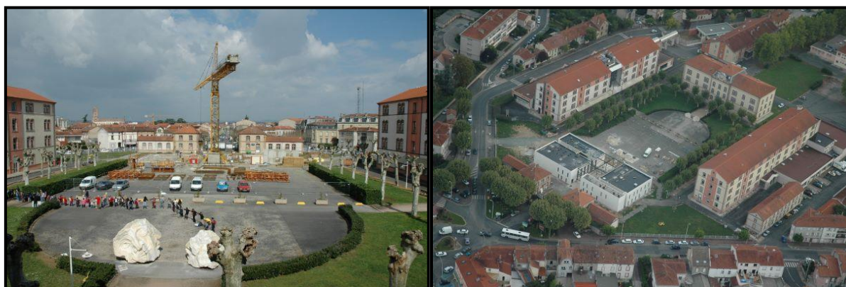
Photo 7 : Première phase de transformation de la caserne Lapérouse en campus universitaire. Source : ARCHAMPO 339
