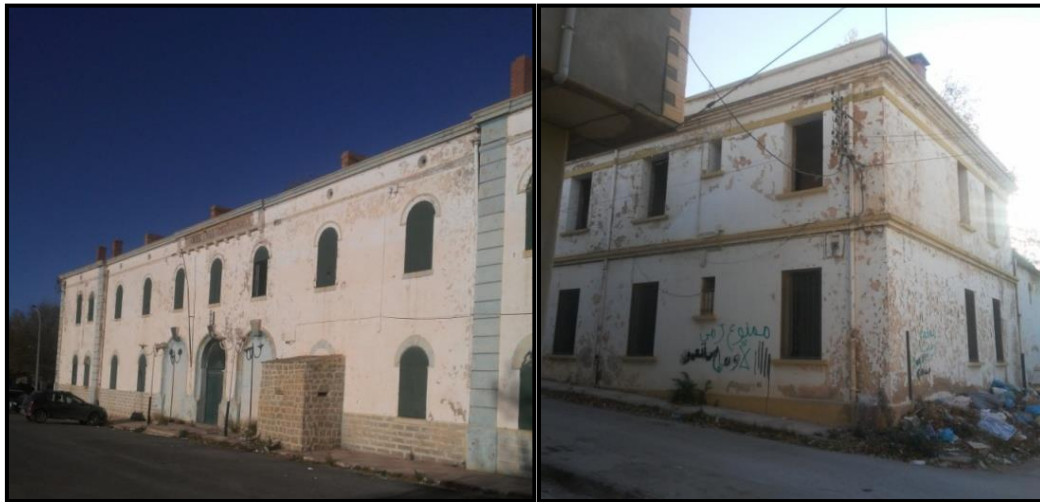
Photo 28 : Vues sur la caserne de la gendarmerie en état de friche. Source : Auteur
