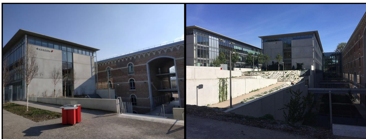
Photo 14 : Vues sur les nouvelles constructions au nord du grand casernement. Source : Cicanord 373
