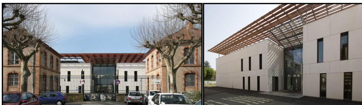
Photo 8 : Seconde phase de transformation de la caserne Lapérouse en campus universitaire. Source : ARCHAMPO, op.cit.
