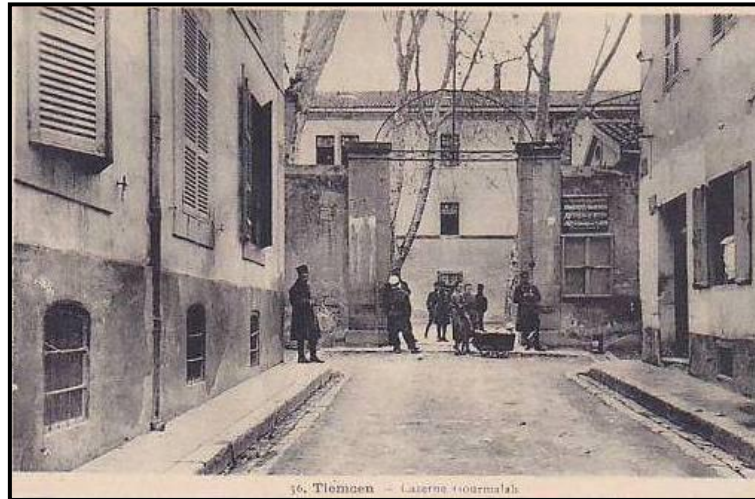
Photo 25: Vue sur l'entrée principale de la caserne Gourmalah. Source : Delcampe 542
