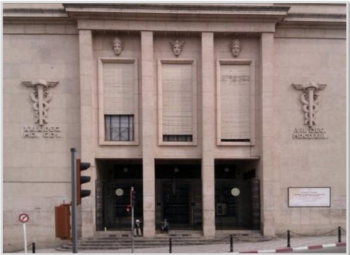
Figure 19: Le Palais Consulaire -Élément Structurant et Significatif de la Ville de Mostaganem
