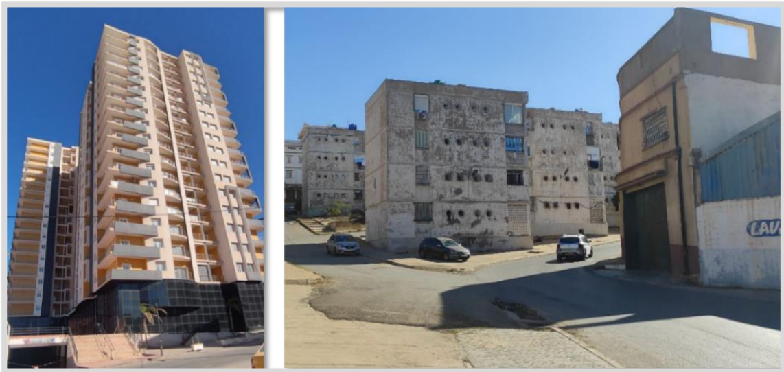
Figure 22 : Des photos illustrant les problèmes architecturaux à Mostaganem
