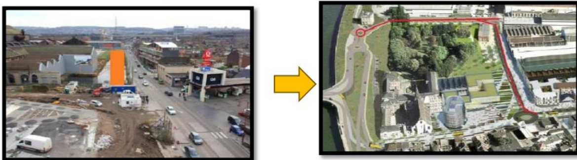
Figure 39: la nouvelle voirie.
