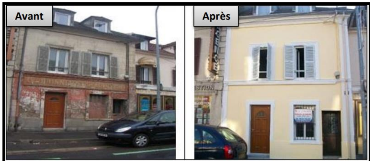
Figure 10: Exemple du ravalement de façade.
