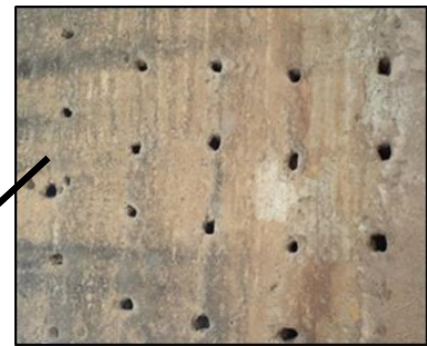
Figure 107: Trou de coffrage des murailles de Mansourah (Source : L'auteur)
