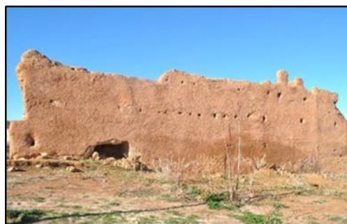
Figure 42: La texture du pisé de l'enceinte d'El Mansourah
