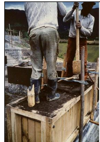
Figure 15: Le coulage de la terre à pisé
