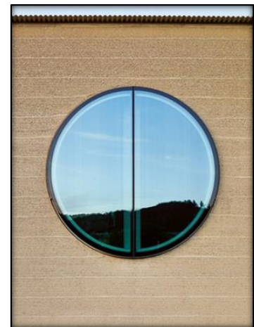
Figure 32: Fenêtre de maison des Plantes Ricola
