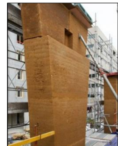
Figure 29: Mur en pisé
