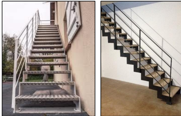
Figure 127: Escalier métallique extérieur et intérieur (Source: Google image)
