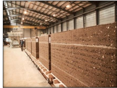
Figure 31: La préfabrication des modules en pisé pour la maison des Plantes Ricola
