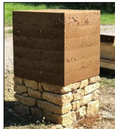
Figure 14: Un soubassement en pierre
