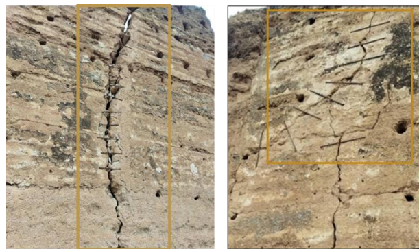
Figure 44: Les agrafes de l'enceinte d'El Mansourah
