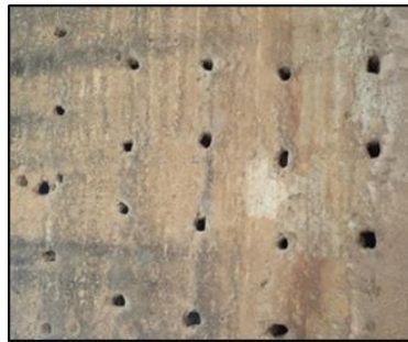
Figure 41: Les trous de coffrage de l'enceinte d'El Mansourah
