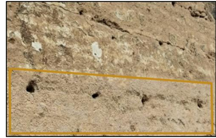
Figure 43: La reprise d'enduit sur l'enceinte d'El Mansourah
