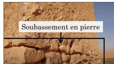
Figure 23: Le soubassement en pierre de ksar ben Haddou
