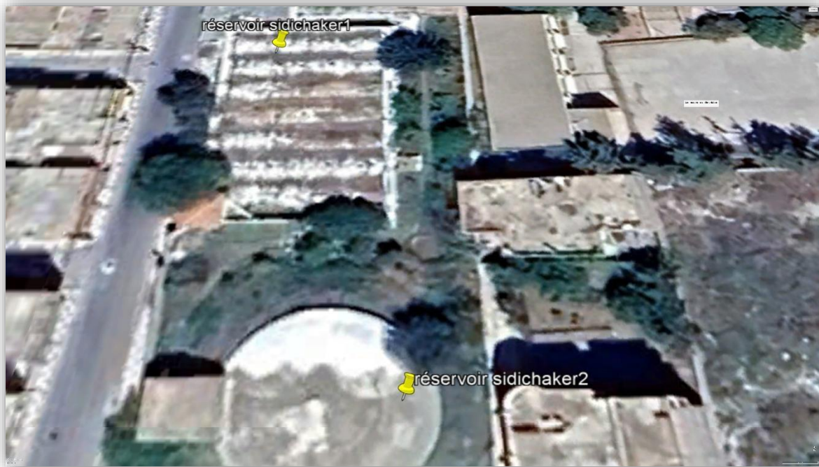
Figure II.5: Les deux réservoirs Sidi chaker le circulaire et le rectangulaire.
