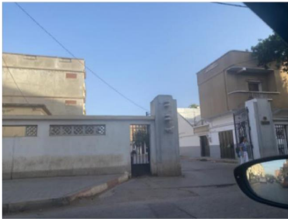
Clôture, accès mécanique central et deux accès piétons
