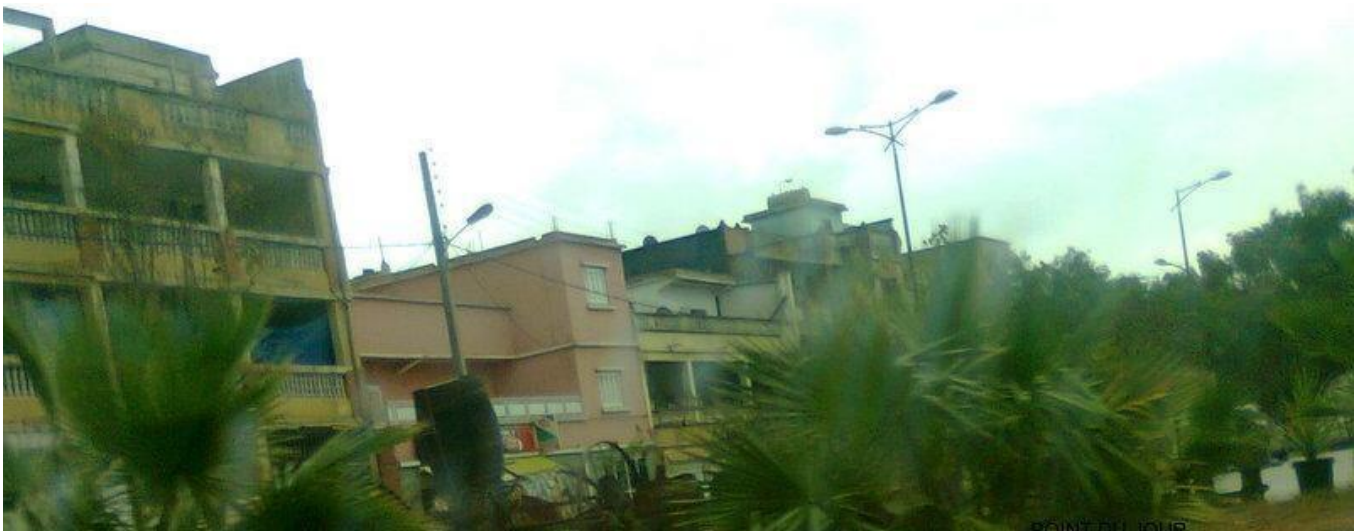
Figure 83: disparité architecturale des lotissements a minima à Protin. Source : auteure, 2024
