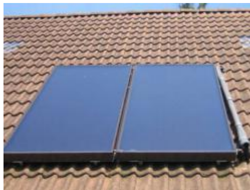
Figure (0.9). Capteur solaire thermique plan vitré à air (Photo prise).
