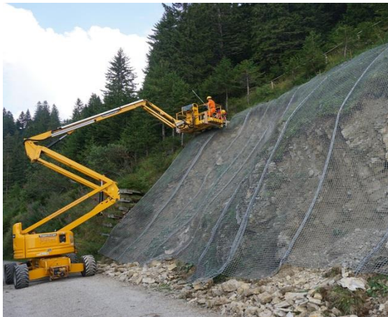
Figure 1.6 Géogrille renforcée (Oran)
