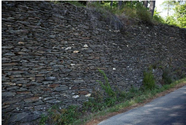
Figure 1.12 Mur de soutènement
