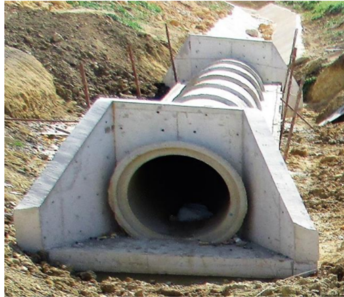
FIGURE 2.11 – La tête de la buse [20]
