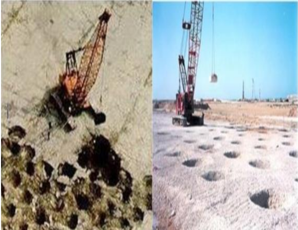
Figure I.12. Technique de compactage dynamique.
