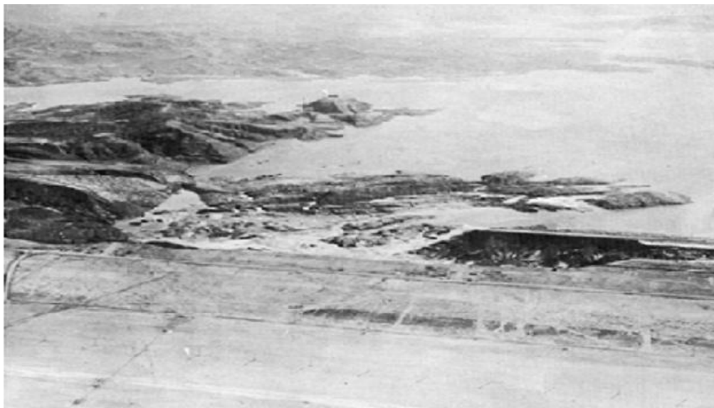
Figure I.3. Vue aérienne de la rupture de barrage de Fort Peck (corps de l'armée des États-Unis d'Ingénieurs, 1939, d'après Mike Jefferies et Ken Been, 2006)
