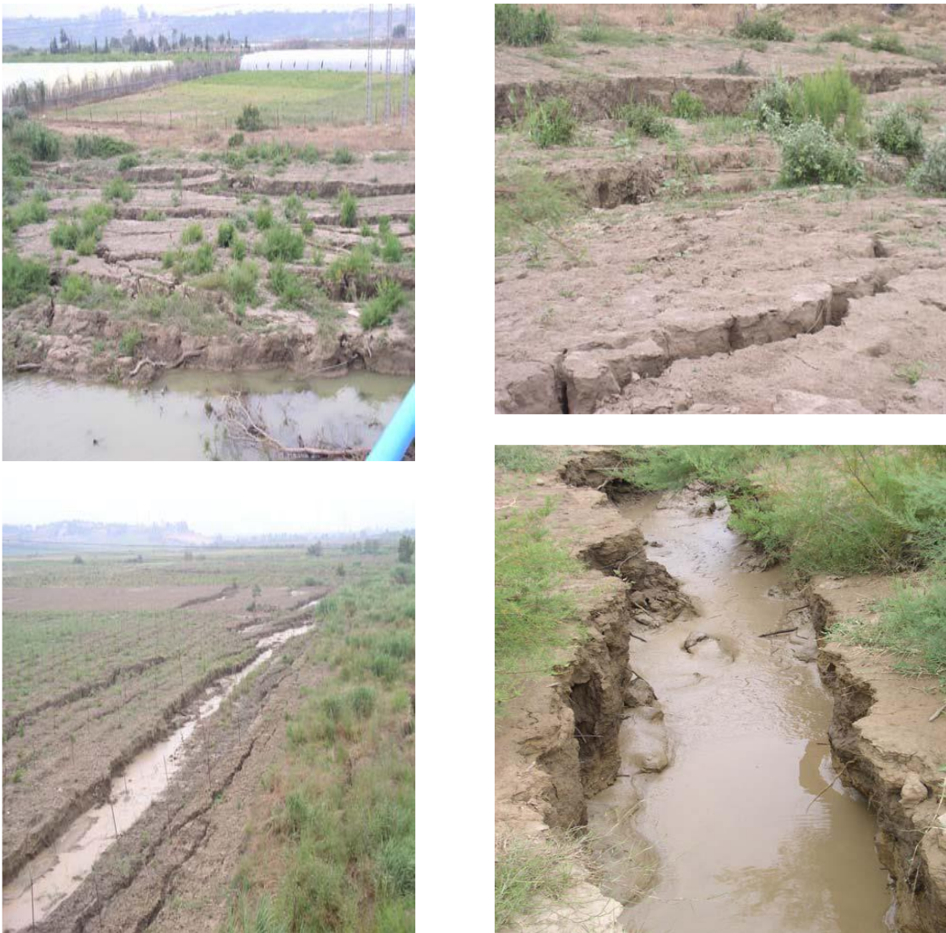
Figure I.2. Liquéfaction du sol aux abords de l'oued Isser
