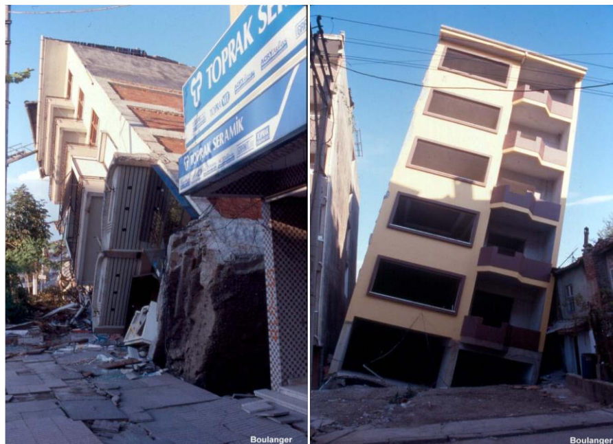
Figure I.6. Dommage des édifices, Adapazani, Turki, 1999.
