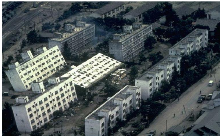
Figure I.4. Inclinaison des bâtiments d'appartements de Kawagishi-cho à Niigata au Japon dues à la chute de la capacité portante du sol par liquéfaction (d'après Peter M. Byrne et al, 2008).
