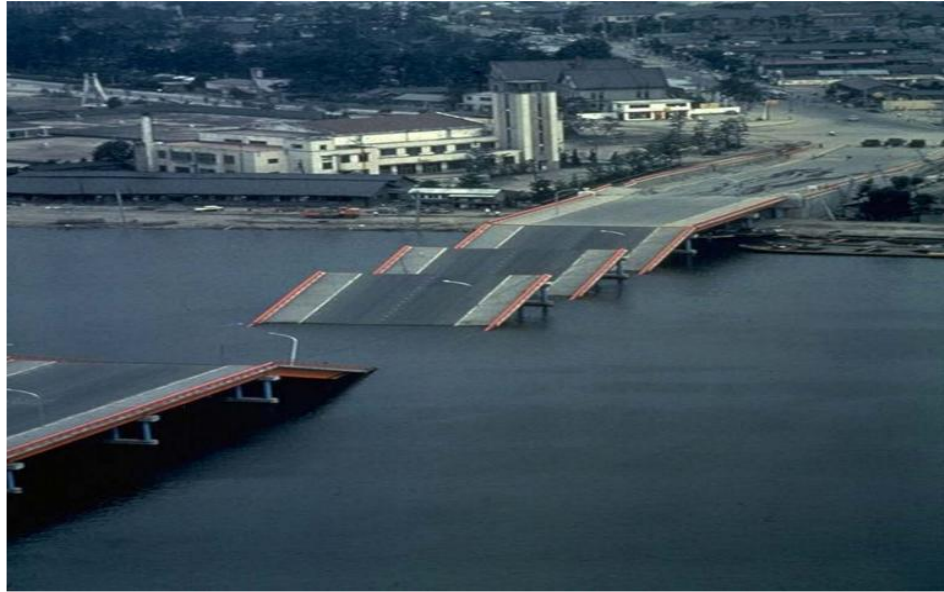
Figure I.5. Rupture du pont de Showa, à Niigata au Japon, dues à l'épandage latéral dans le sol (d'après Peter M. Byrne et al, 2008).
