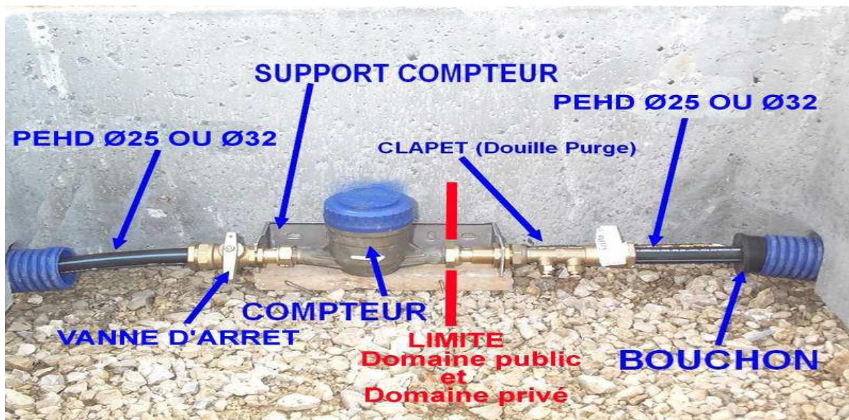
Figure I.6 : Les équipements d'un branchement hydraulique [11].
