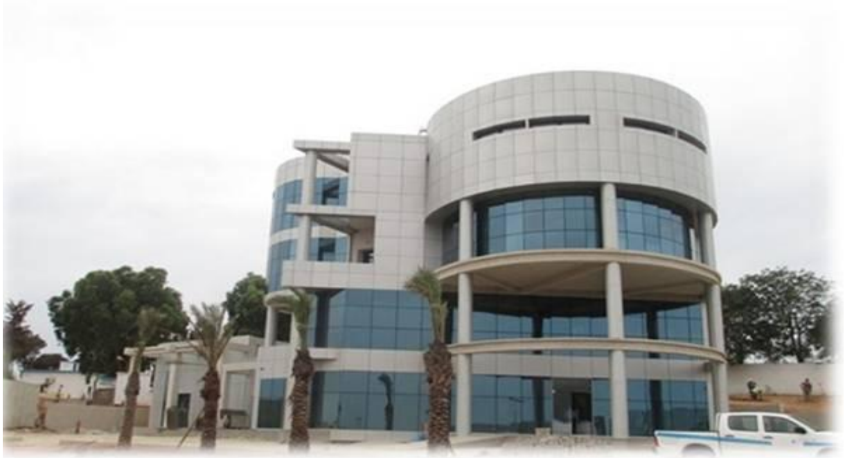
Figure II.4 : le bâtiment technologique de la SEOR [26].
