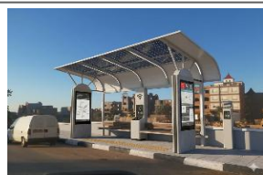
Figure 88: arrêt de bus existant; Source : auteur
