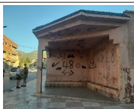
Figure 92: arrêt de bus
