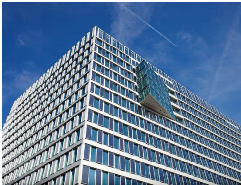
Figure 1: The Edge, Amsterdam (façades équipées de capteurs et de panneaux photovoltaïques); Source: https://edge.tech/portfolio/the-edge
