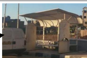
Figure 89: arrêt de bus après la rénovation
