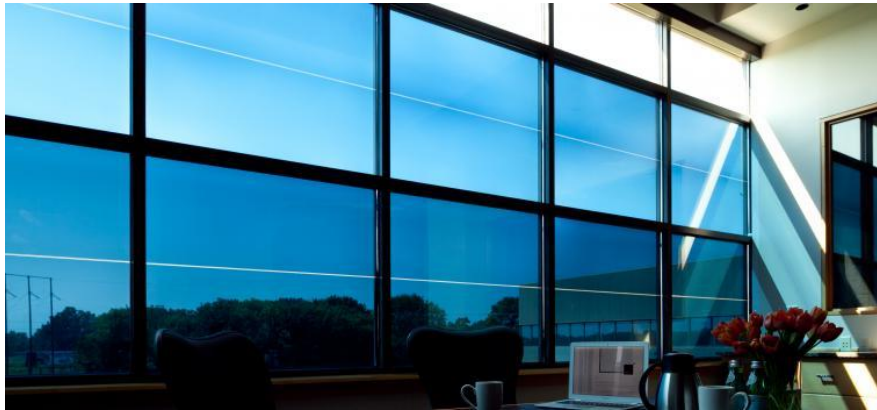
Figure 4: verre électro chromique ; Source : https://www.batiadvisor.fr/verre-electrochrome
