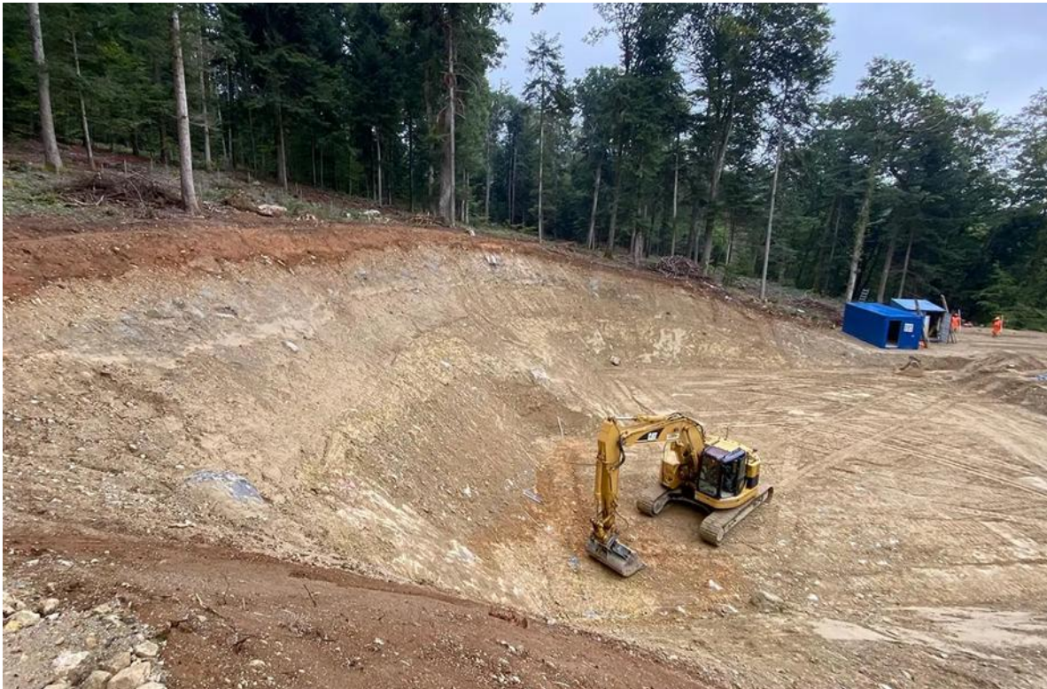
Figure 1-14 : Vue réelle d'un site de terrassement pour excavation au pied d'un talus.
