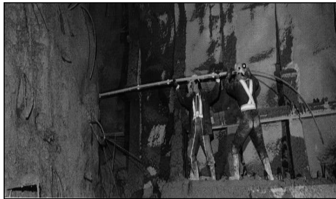
Figure 1.7 Pose de boulons au front de taille [11]
