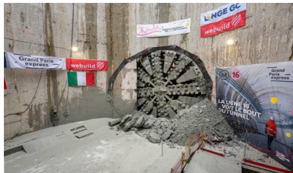
Figure1.5 excavation par TBM [8]
