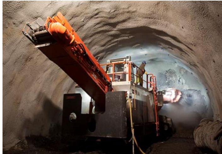
Figure 1.4 Creusement par attaque ponctuelle [7].
