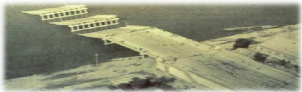
Fig.1.15 : La liquéfaction et tassement des sols lors des séismes de Niigata 1964 [3]
