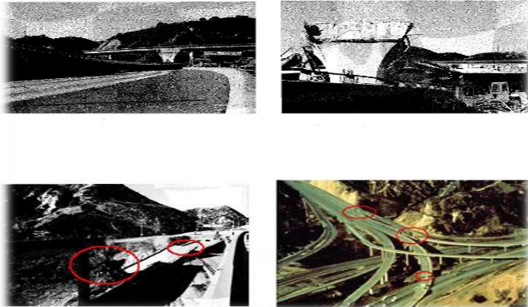
Fig.1.9 : Pont 14 South et Pont 14 North Connector, Séisme de Northridge -Los Angeles 1994, Séisme de San Fernando -Californie 1971 [4]
