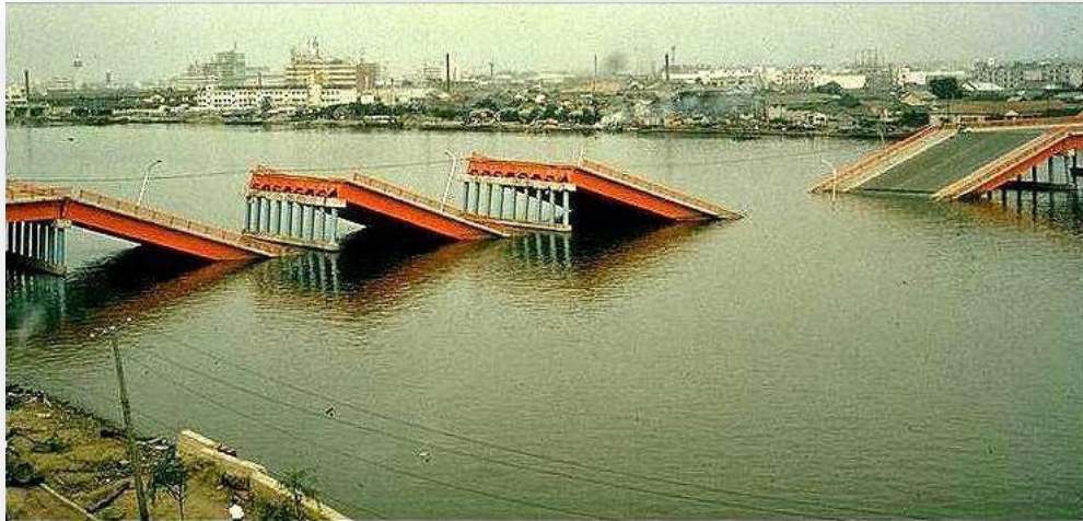
Fig.1.5 : effondrement des travées du pont de Showa suite au séisme Niigata[12]
