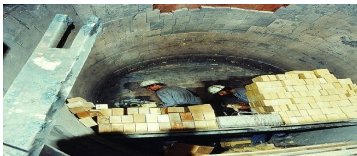
Figure [I.5]: Restauration de l'habillage intérieur d'un four en briques réfractaires
