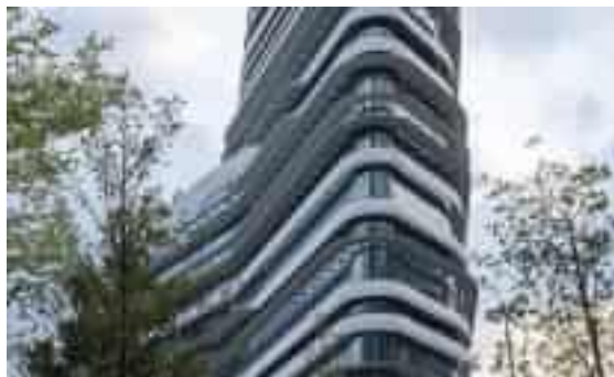
Figure 89. Photographie du projet Jokey club innovation de Tower
