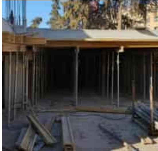
Figure 80. Exemple structure en Mur voile au sous-sol « Projet résidence Amani 3 »
