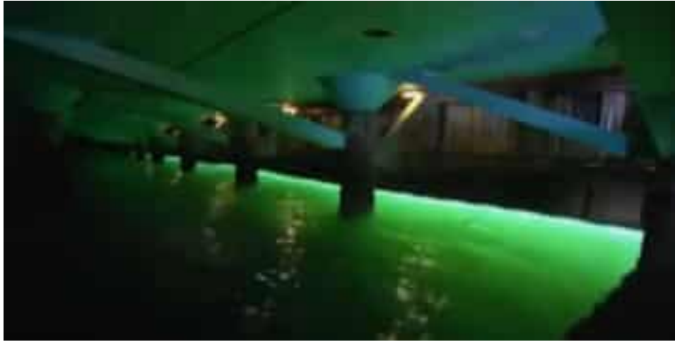
Figure 95. Photographie de L'eau de mer dans le bassin de 1m au sous-sol
