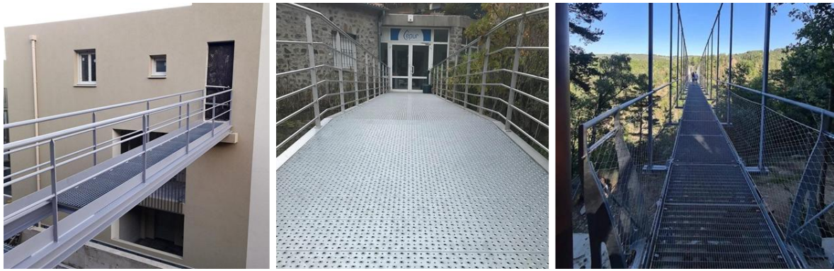
Figure 110 : Passerelles en charpente métallique. (Source : Batisharp.com, passerelles en charpente métallique).
