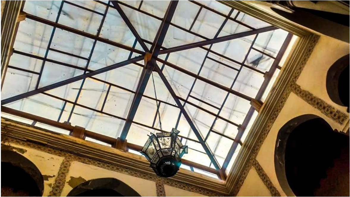
Figure 32 : Structure de la verrière couvrant le patio central. (Source : Prise de vue personnelle , 2025).
