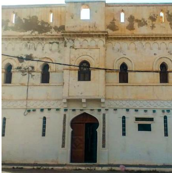
Figure 31 : Façade principale. (Source : Prise de vue personnelle, 2025).
