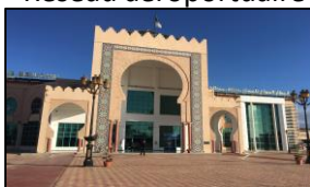
Figure 23 : aéroport Messali Hadj (Source : tripifyapp.com)
