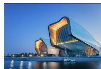
Figure 109: la coque extérieure du musée (Source : archdaily.com)
