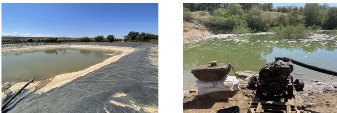
FIGURE II.6 – Géomembrane (5000m 3 ) et source d'eau (1 L/s) Ferme pilote BELAIDOUNI-Med/Algérie
