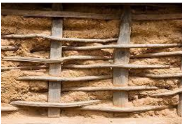
Figure I.6 Mur en torchis
