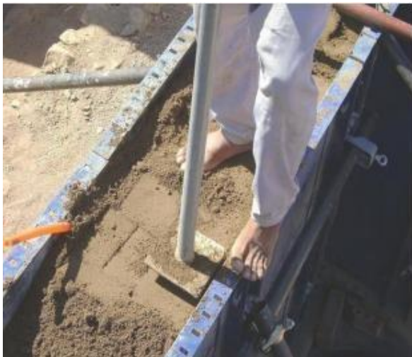
Figure I.5 Compactage des couches de terre crue à l'aide d'un pilon
