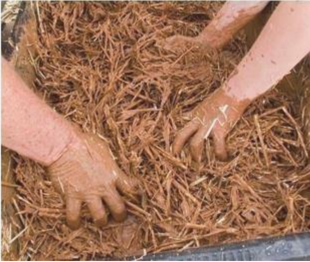
Figure I.8 Mélangé sol argileux et la paille
