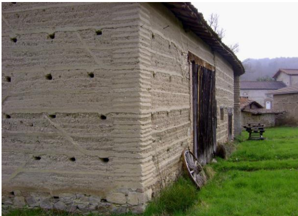
Figure I.3 Construction en pisé
