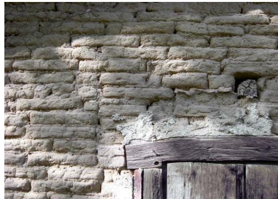
Figure I.4 Mur en brique de terre crue
