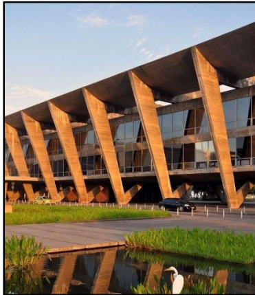
Figure 77. Traitement de façade vertical incliné
