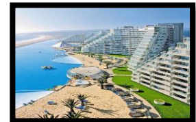
Figure 71 : Vue générale du complexe
