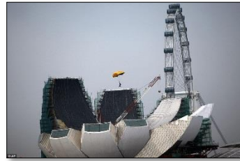
Figure 89 : Chantier du musée
