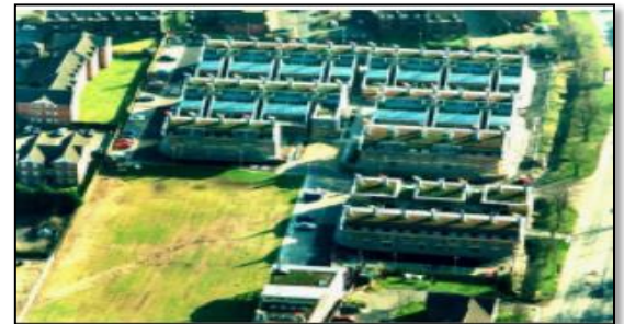
Figure 33: Vue de l'ensemble du projet Bed ZED
