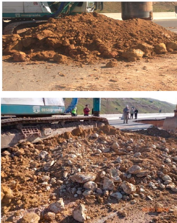
figure 5.6 : Matériaux extraits lors du forage des pieux de stabilisation
