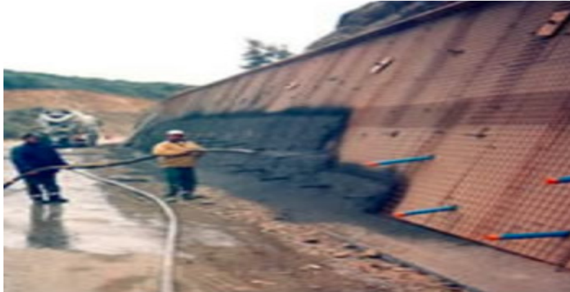
figure 1.16 : Mise en œuvre du béton projeté
