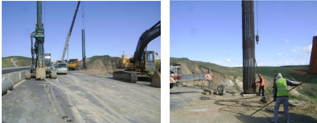
figure 5.7 : Réalisation des pieux de stabilisation au niveau de la section de glissement PK52+093~PK52+200
