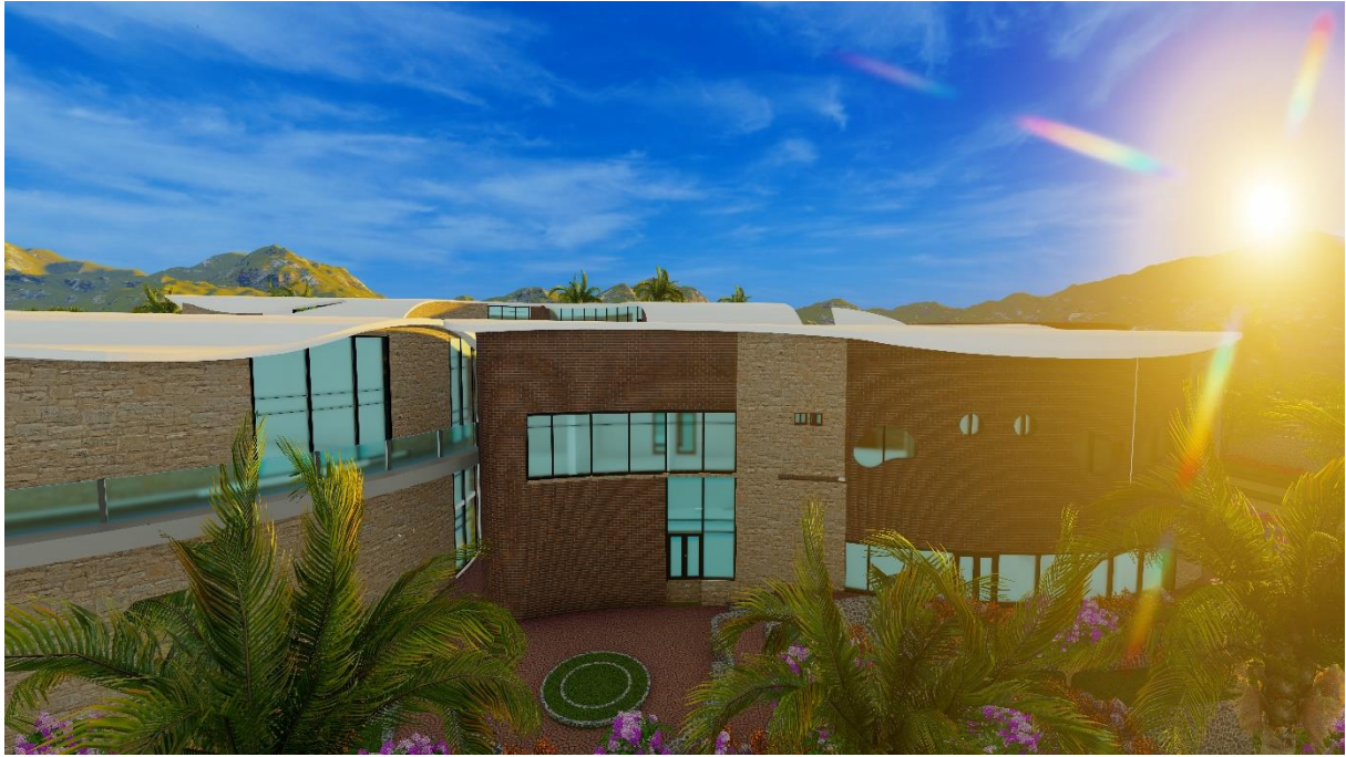
Vue de la façade latérale Nord
