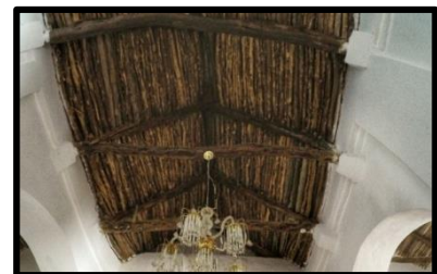
Figure 37. La toiture en touilla
