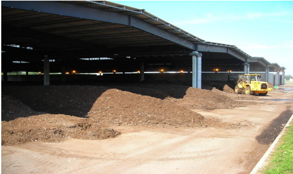
Figure 0-12: Système de compostage en lits rectangulaires remués Source : https://www.smicval.fr/le-compost-du-smicval ; 26-03-2021
